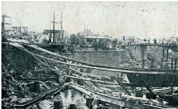
図3 「東京大震災実況 神田橋」(『震災絵葉書』より) 1923年 崩落した神田橋の様子。神田橋は千代田区大手町1丁目から神田錦町1丁目と内神田1丁目の間に懸かる橋。
