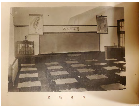
図3 再建された淡路小学校の普通教室の様子（同）
