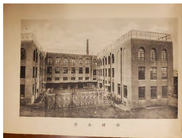
図2 淡路小学校学校全景（同）
